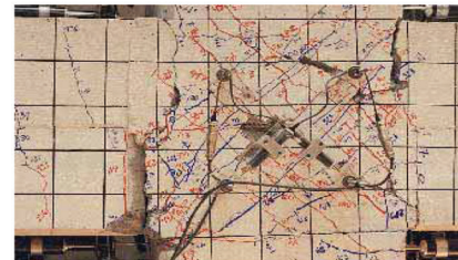
(d) Cracks on the NAC inner joint 22
