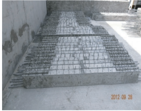
(b) Precast beams
